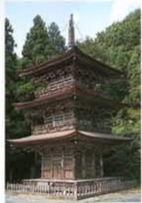
慈恩寺(三重塔)
